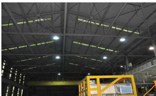
春源鋼鐵汐止廠
